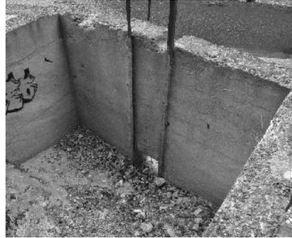
*Figura 16 - Fondo inclinato dello sghiaiatore con guide per saracinesca*
