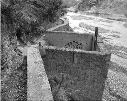
*Figura 15 - Sghiaiatore sul canale d'irrigazione agricolo*
