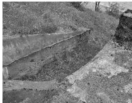
*Figura 20 - Scarico con canale verso il fiume Adda*
