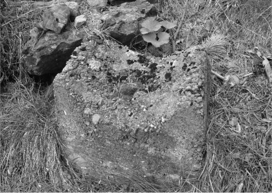
*Figura 12 - Supporto per l'appoggio della condotta forzata*
